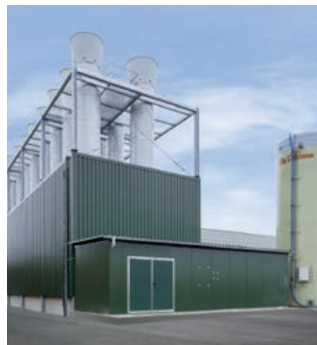
Luchtafvoerkanalen met geïntegreerde Pollo-M
