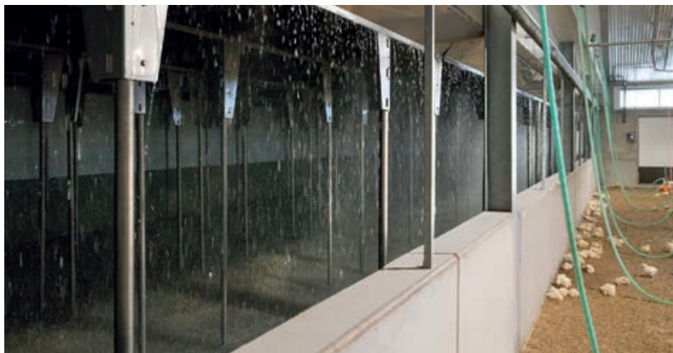
Pollo-M is eenvoudig toegankelijk en doordat het water voortdurend blijft lopen, blijft de filterwand schoon
