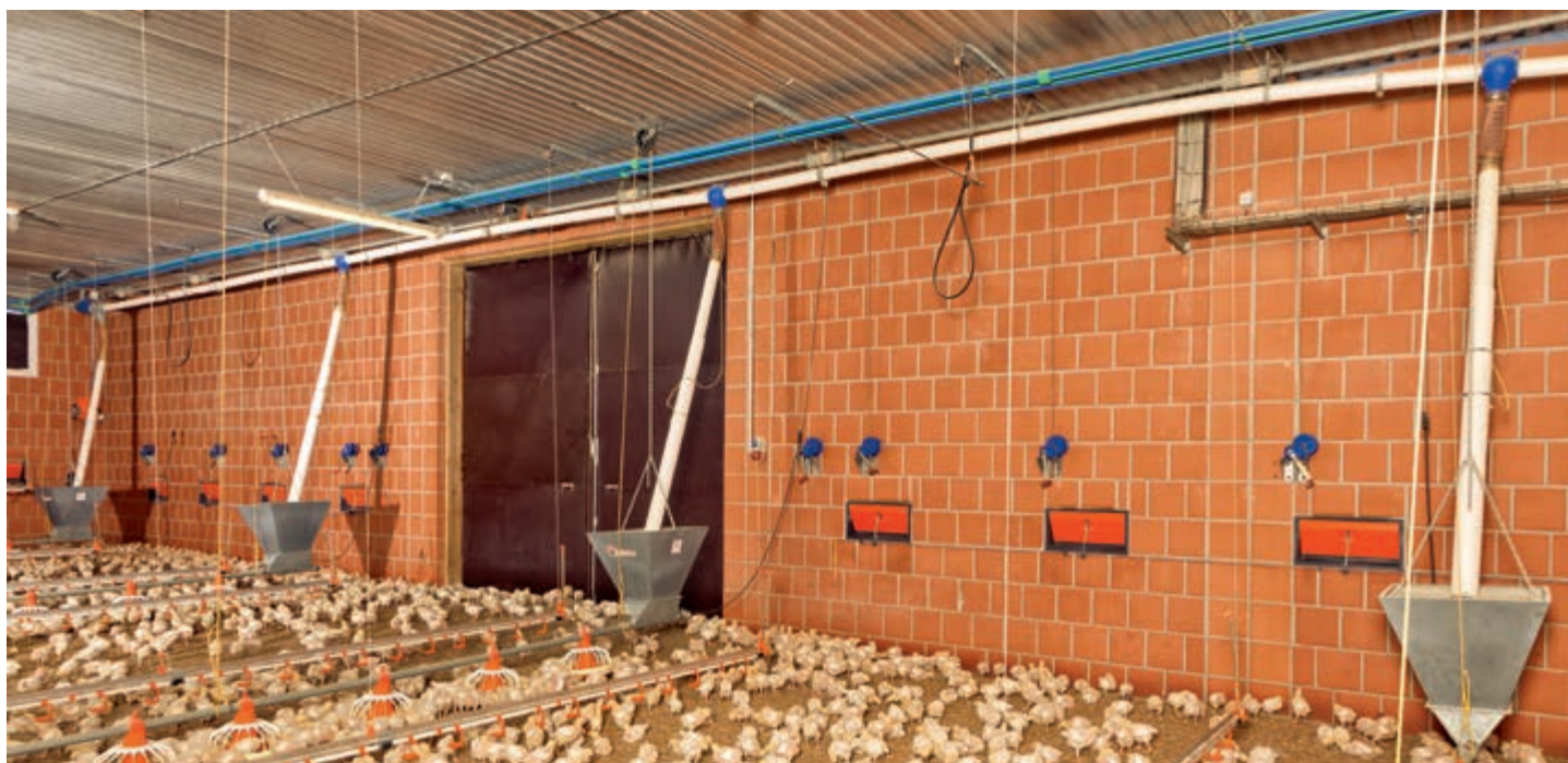
Utilisation des treuils à câble entre autres pour régler de façon optimale la hauteur des rangées d'abreuvoirs selon l'âge des animaux
