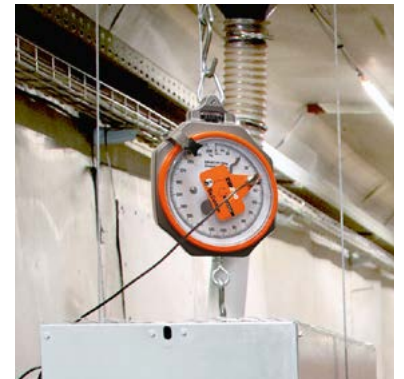
Einsatz der Zeigerkranwaage
