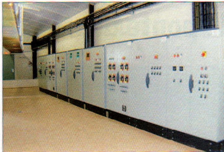
▲ L'impressionnant PC de l'atelier de ponte avec ses différentes armoires de contrôle et de gestion des fonctions automatisées. L'ensemble des données – consommations, températures, ventilation, lumière etc. – peut être consulté et visualiser à distance.
