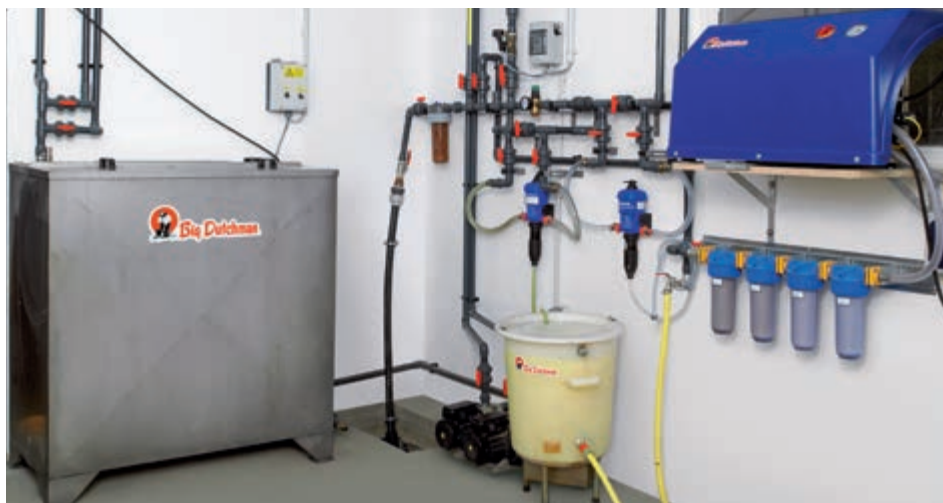
Подсобное помещение с малагобаритным (60 л) и крупногабаритным (1000 л) смесителем для медикаментов из нержавеющей стали
