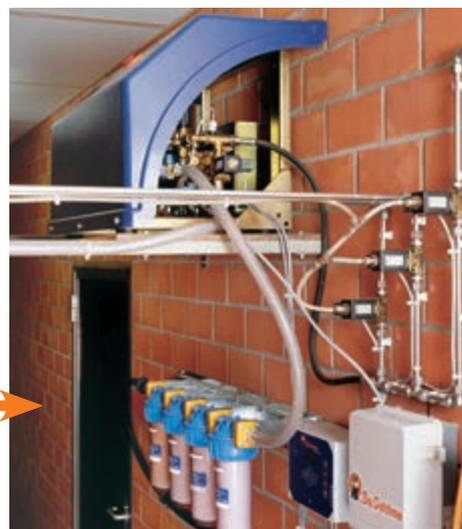
Центральный насос с четырехступенчатым фильтром
