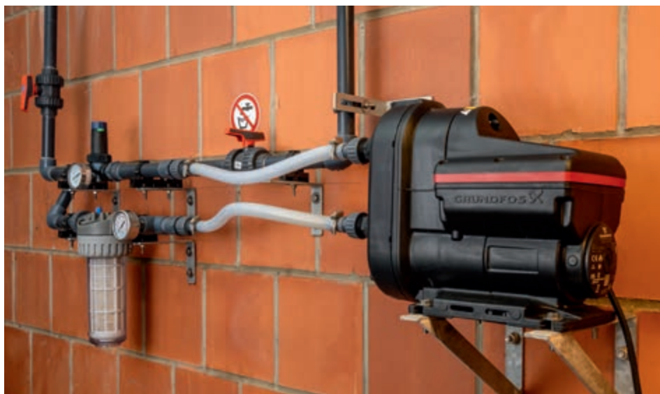
Центральная насосная установка с редукционным клапаном и фильтром
