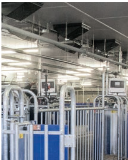
Отапливание помещений с помощью ребристой трубы – идеально в сочетании с потолочными клапанами
