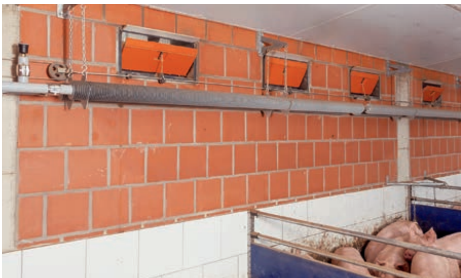
Отапливание помещений с помощью ребристой трубы из алюминия – идеально в сочетании с приточными клапанами CL 1200
