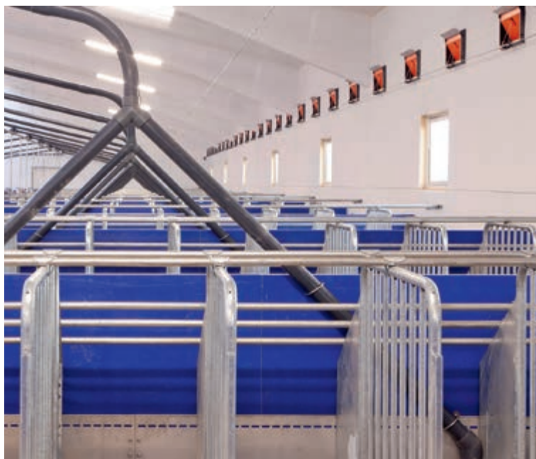
Стенной клапан CL 1211 F с пластиной направления воздушного потока
