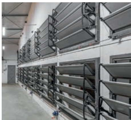
MVT 17 M во фронтовой стене, для туннельной вентиляции
