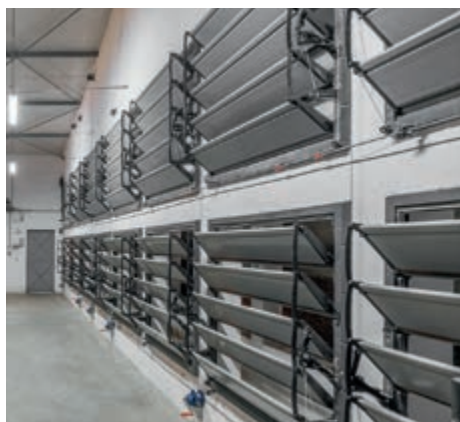
MultiVent 17 M во фронтонной стене, для туннельной вентиляции
