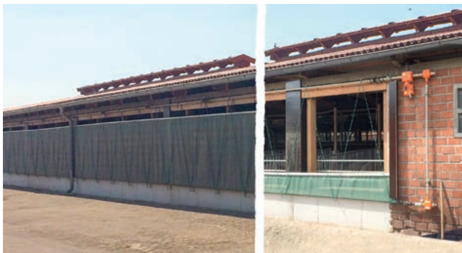
Электроприводные шторы с механизмом открытия сверху-вниз посредством серводвигателя EWA
