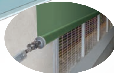
Электроприводные шторы в коридоре Doghouse – открываются снизу вверх
