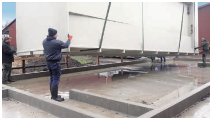
Porcus jest umieszczany na betonowym fundamencie
