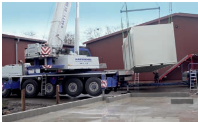
Dźwig podnosi oczyszczalnię powietrza Porcus z przyczepy niskopodwoziowej
