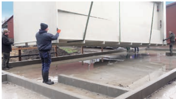
Porcus viene posizionato sul basamento in calcestruzzo
