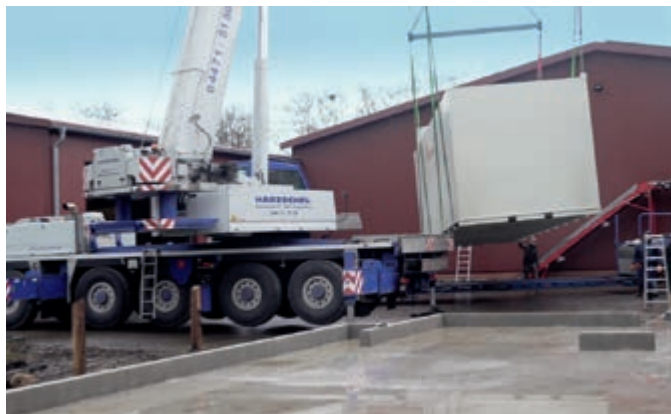
Una gru solleva lo scrubber Porcus dal pianale di carico
