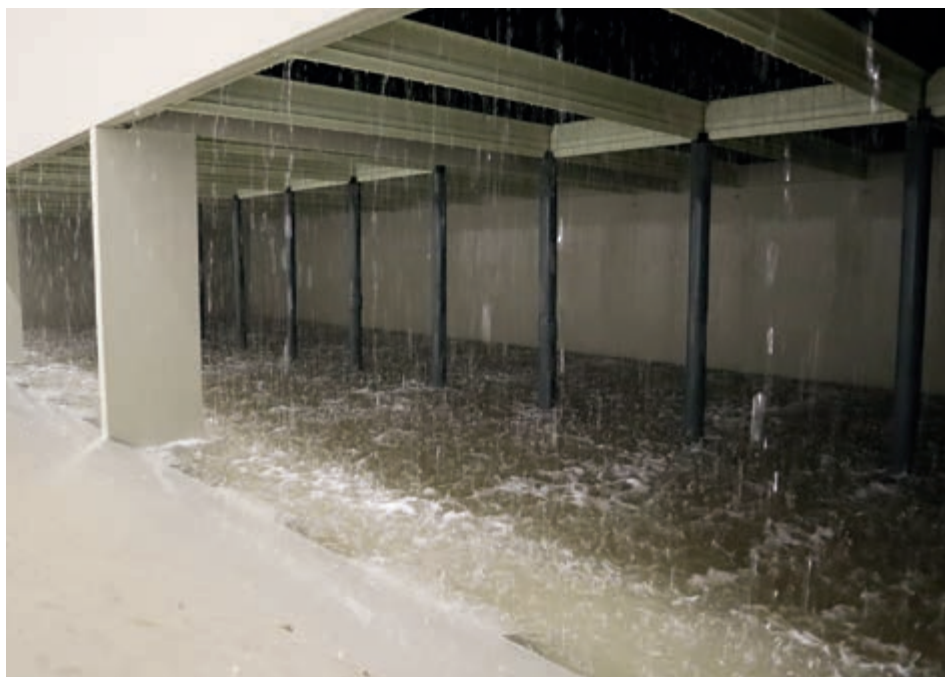
Scrubber Porcus durante il funzionamento
