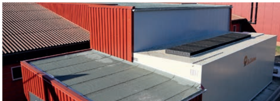
Retrofit di scrubber Porcus
