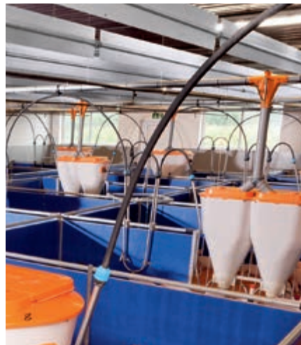
Tubo Twin, meno polvere sulle tubazioni
