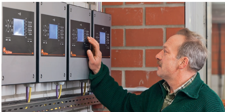
Chaque unité TriSort pro est commandée depuis un opérateur ; ici il se trouve dans un local de service
