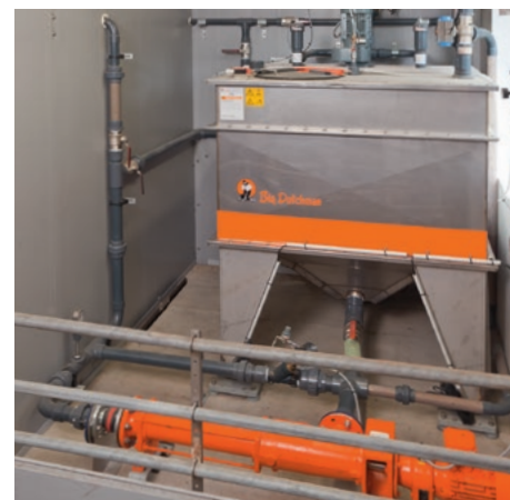
Cuve de stockage pour l'approvisionnement du système CallMatic pro en ingrédients
