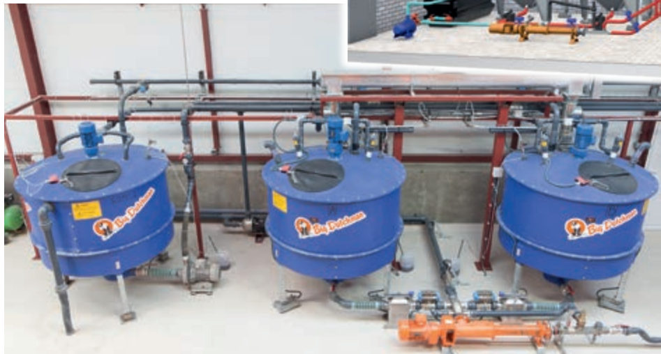
Configuration 2-cuves avec cuve de reste
