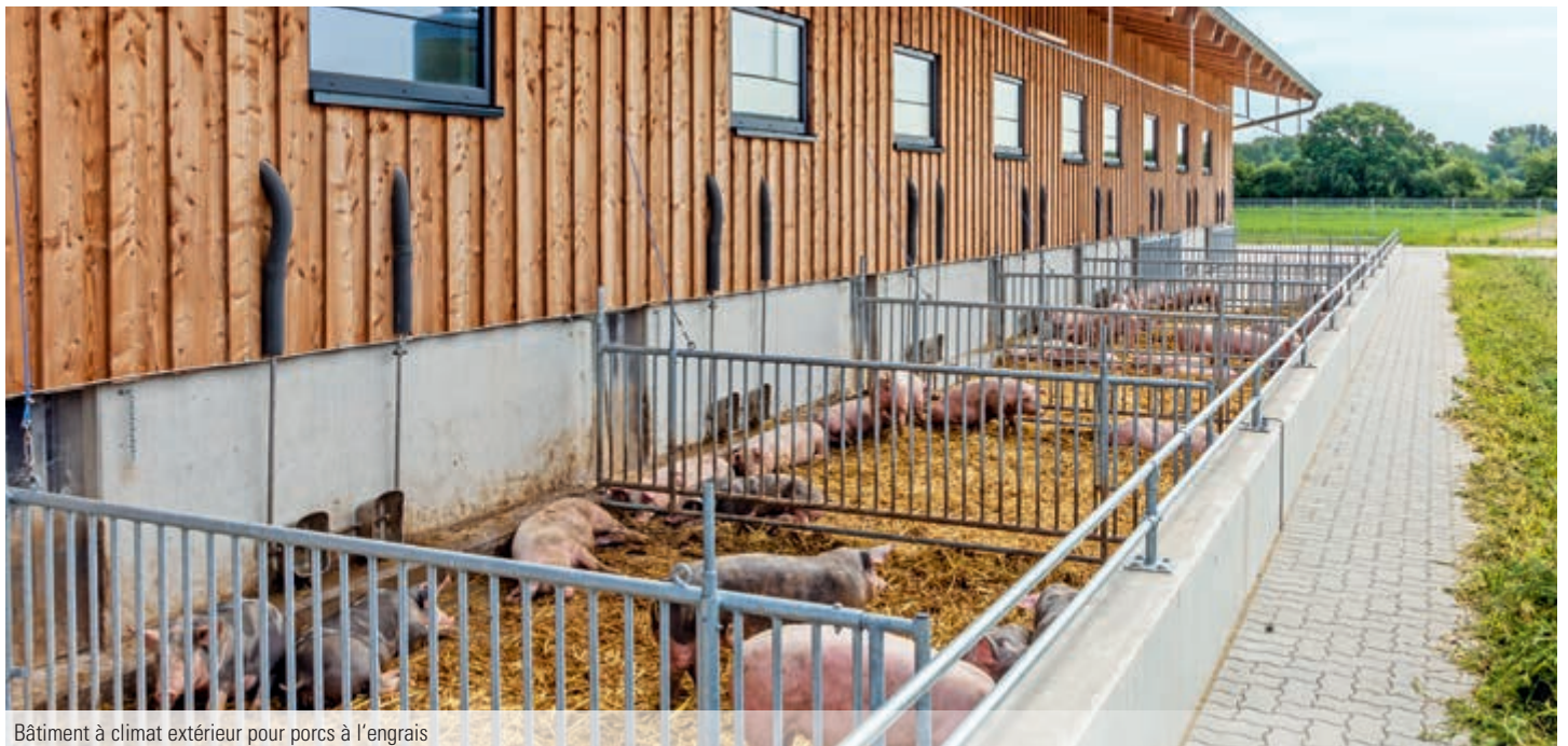
Bâtiment à climat extérieur pour porcs à l'engrais
