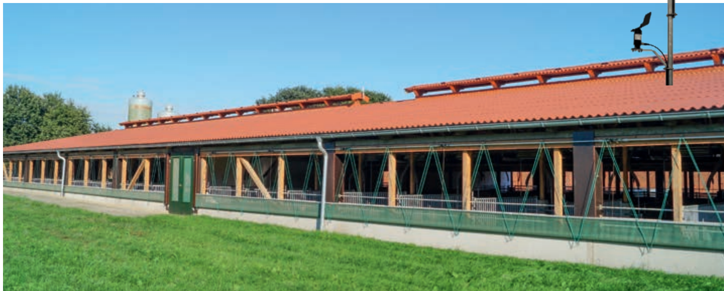
Bâtiment à climat extérieur avec rideau pour la protection contre les intempéries
