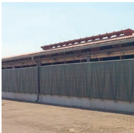
Rideau roulant ouvrant du haut vers le bas avec le servomoteur EWA
