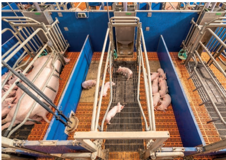
Système de caillebotis en matière plastique avec plaques chauffantes intégrées pour les porcelets et caillebotis en fonte rafraîchissants pour la truie
