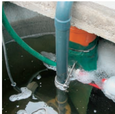
Utilización de una bomba de inmersión para suministro de agua al CoolBox
