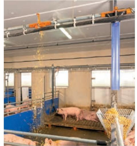
Válvula neumática para dosificación de paja en engorde
