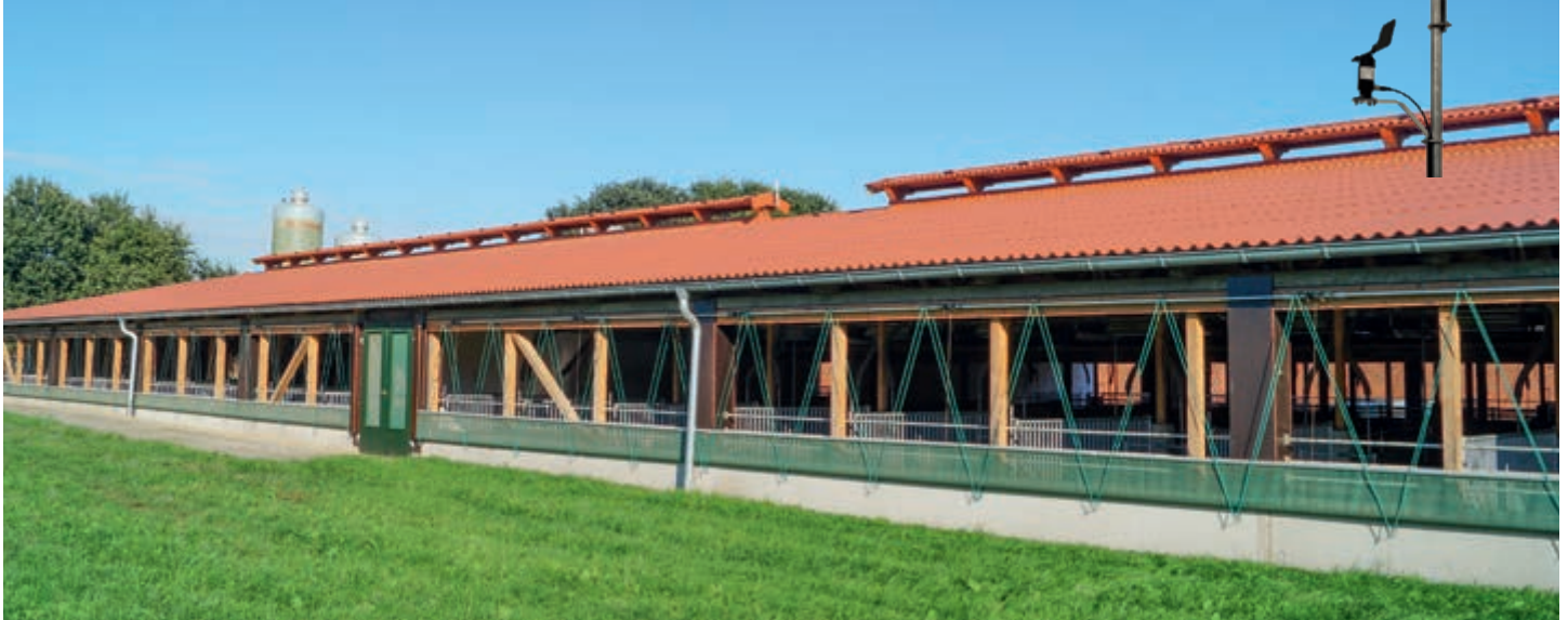
Nave de clima exterior con cortinas como protección frente a las influencias atmosféricas
