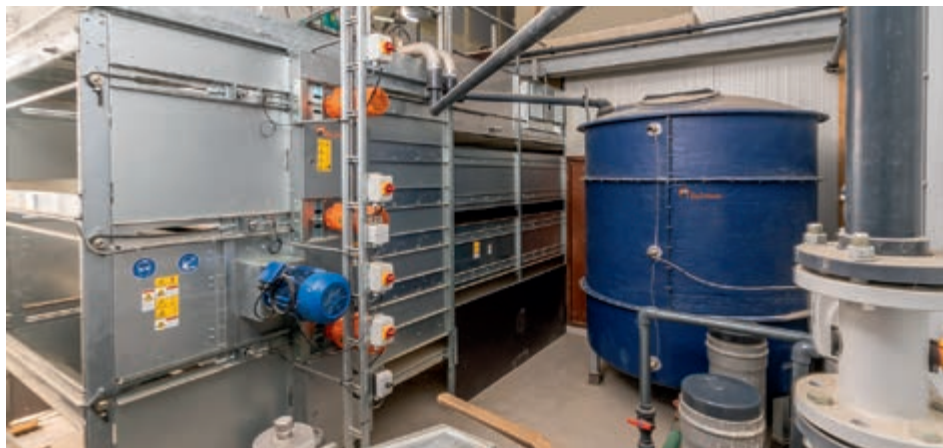
Depósito de la fase líquida en el tanque de almacenaje
