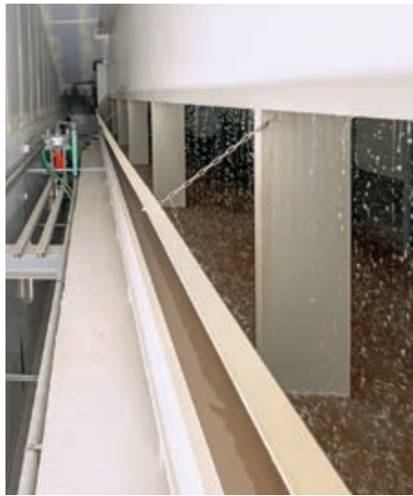
Uso de un depurador de aire para limpiar el aire con amoníaco que se desprende de OptiSec Porco
