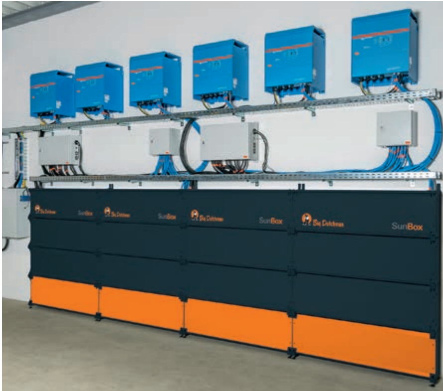
16 moduler med en samlet kapacitet på 224 kWh
