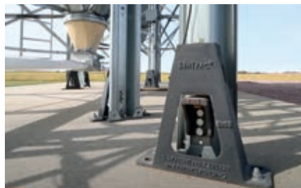
QuadScale vejemodul kan eftermonteres uden at løfte hele siloen
