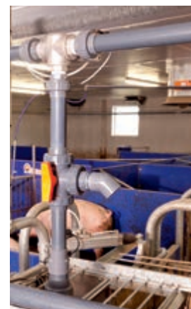
Pneumatisk kugleventil
