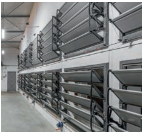
MultiVent 17 M in der Giebelwand für Tunnelventilation
