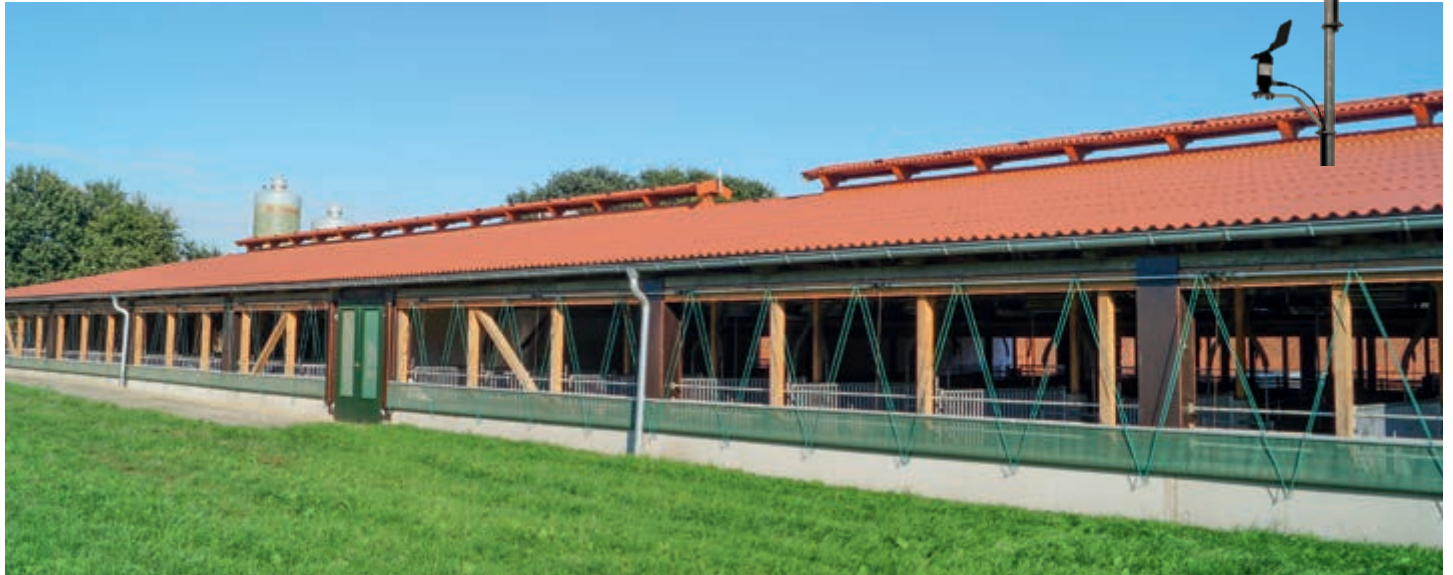
Außenklimastall mit Gardine als Schutz vor Witterungseinflüssen
