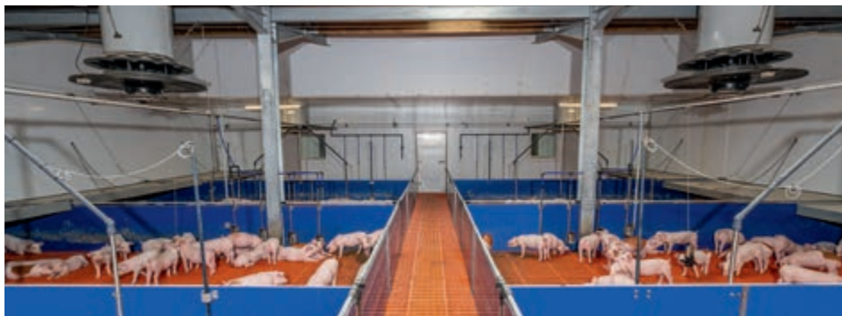
Einsatz des F.A.C. 2 in einem Ferkelaufzuchtstall
