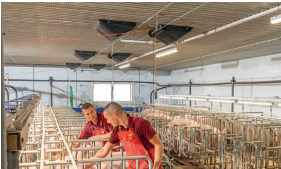
Einsatz der CombiDiffus-Ventilation in einem Deckzentrum
