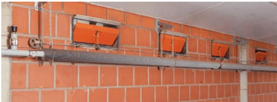
Alu-Rippenheizung – ideal einsetzbar in Kombination mit CL 1200-Zuluftventilen
