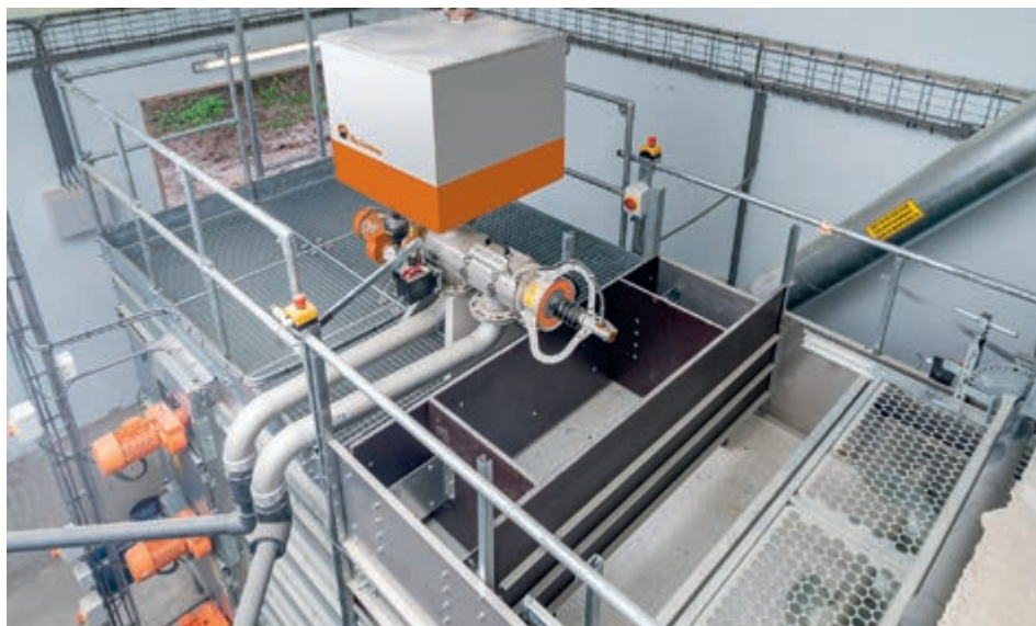
Schneckenpresse separiert die Rohgülle in eine feste und flüssige Phase
