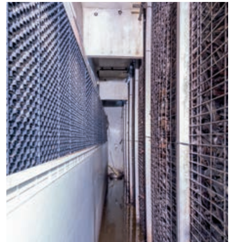
Vlevo: odlučovač kapek, vpravo: biologická filtrační stěna s náplní kořenového dřeva
