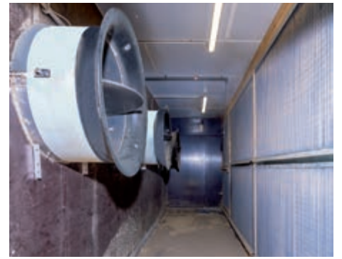
Přetlaková chodba s předřazeným prachovým filtrem StuffNix
