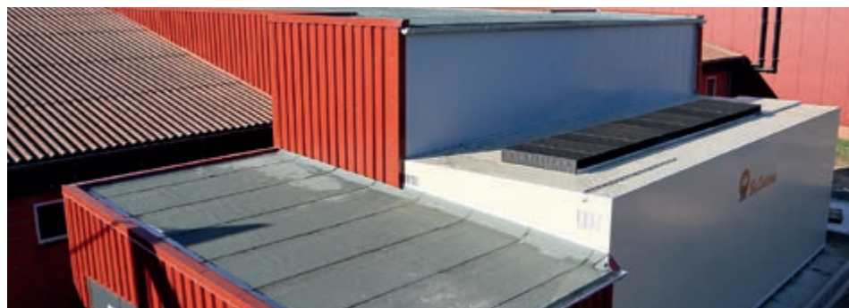
Dodatečná montáž čističky vzduchu Porcus
