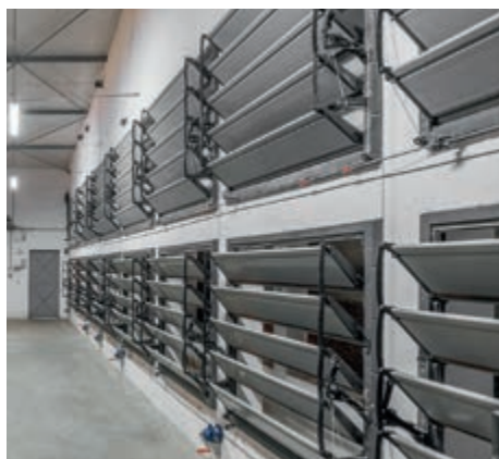
MultiVent 17 M на челната стена при тунелна вентилация
