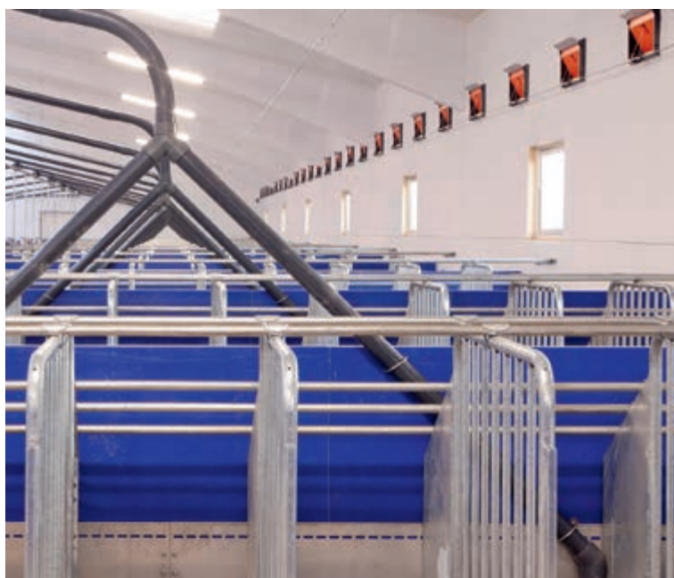
Клапа CL1211 F с насочваща козирка за въздушния поток
