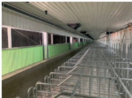
Сектор „Заплождане“ със завеси чрез навиване и охлаждащ панел при напречна тунелна вентилация (Cross-Tunnel)
