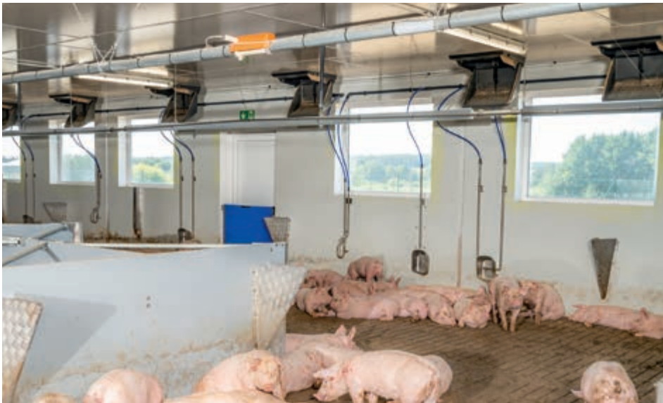
CL 1540 – през лятото капакът на клапата е широко отворен
