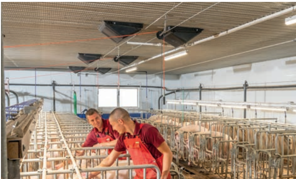
Комбинирана дифузна вентилация при заплождани свине-майки
