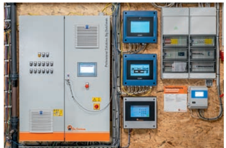
Sterowanie klimatem i zadawaniem paszy – wszystko jest całkowicie zautomatyzowane
