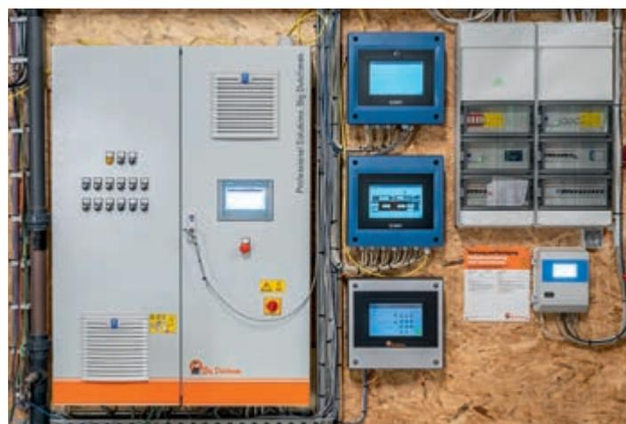
Control de climatización y de alimentación – todo completamente automatizado
