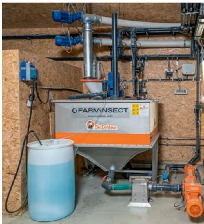
El mezclado del alimento se realiza controlado por ordenador en dos tanques de mezclas. Ambos tanques de mezclas se sitúan sobre células de pesaje.
