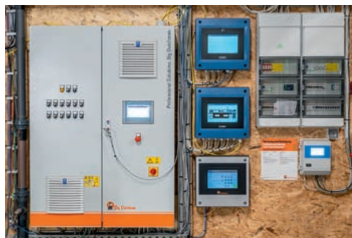
Klima- und Fütterungssteuerung – alles läuft vollautomatisch
