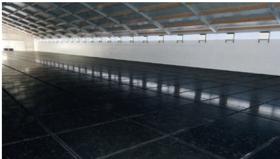
Vista di un solaio intermedio in pannelli di plastica prima dell'installazione del sistema al secondo piano
