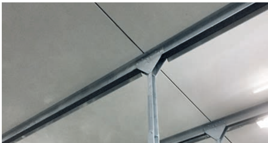
La superficie bianca e liscia del lato inferiore dei pannelli in plastica permette all'aria esterna di scorrere trasversalmente e senza ostruzioni all'interno del capannone e aumenta la luminosità del piano inferiore
