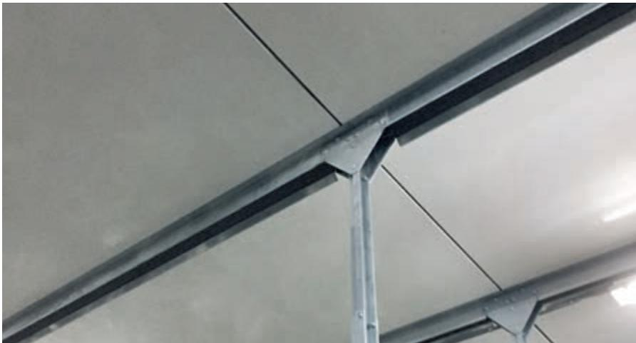
La cara inferior blanca y lisa de las placas de plástico permite el flujo de aire de entrada sin obstáculos en la dirección transversal a la nave y, además, el piso inferior queda más luminoso
