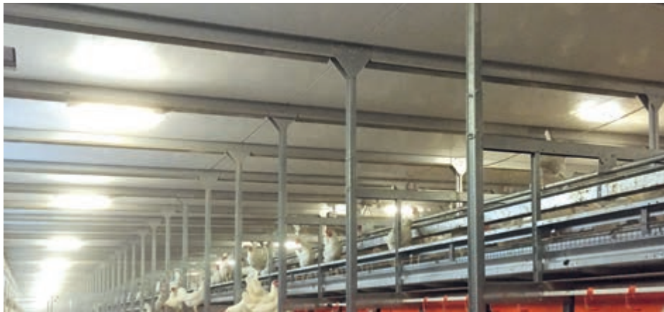
La cara inferior blanca y lisa de las placas sintéticas permite el flujo transversal del aire entrante sin obstaculizarlo
