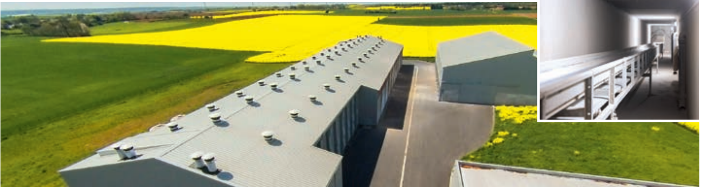
Çevre dostu çözüm: küresin uzun kenarında 205.000 yumurtacı için iki OptiPlate kurutucu; kurutulmuş gübre yeraltındaki gübre deposuna taşınır
