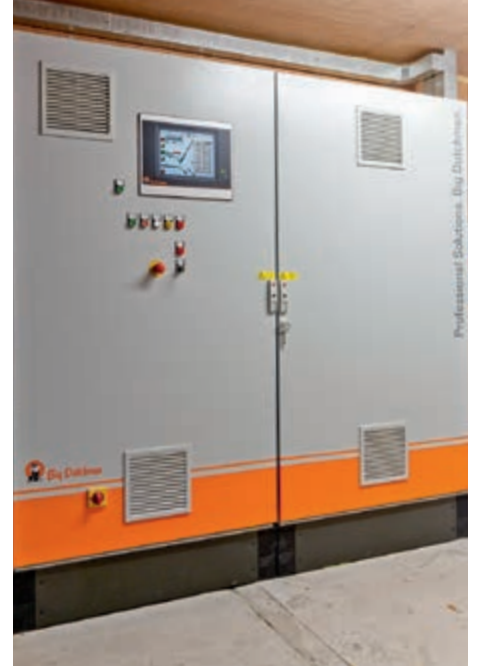
Amacs modüllü kontrol dolabı »OptiSec gübre kurutma tüneli«
