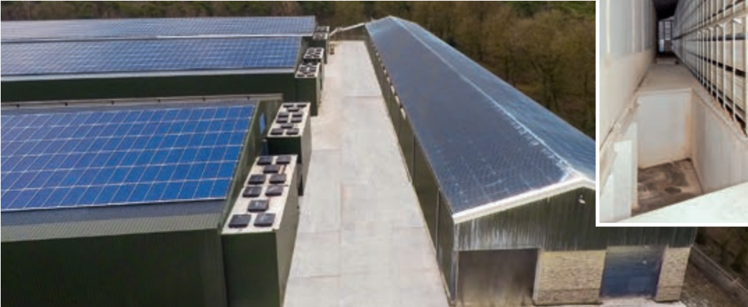
Düşük maliyetli çözüm: her biri 90.000 kapasiteli yumurtacıya sahip üç yumurtacı küresi için bir OptiSec; hava yeraltı tüneli ile kurutucusuna ulaşır
