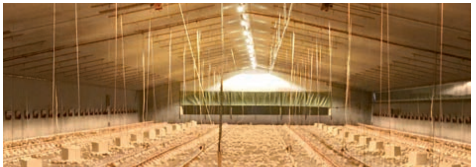
Aurora 540 – оптика «летучая мышь» позволяет сэкономить целую линию в корпусах с плоской крышей
