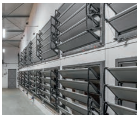
MultiVent 17 M во фронтовой стене, для туннельной вентиляции
