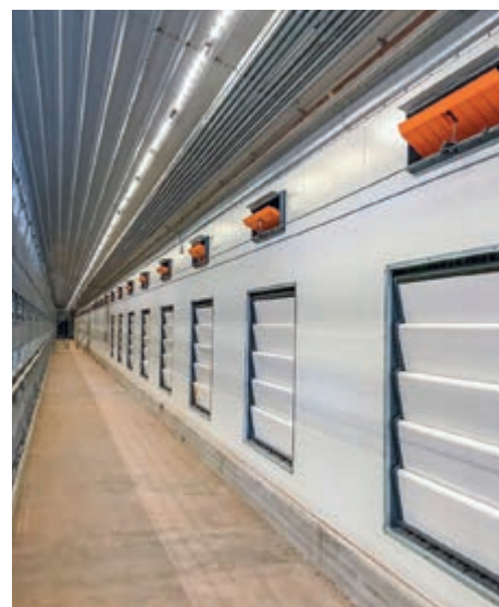
MVT-заслонки и фланцевые клапаны CL-3-1911/F в корпусе с вольерной формой содержания птицы и вентиляцией смешанного туннельного типа
