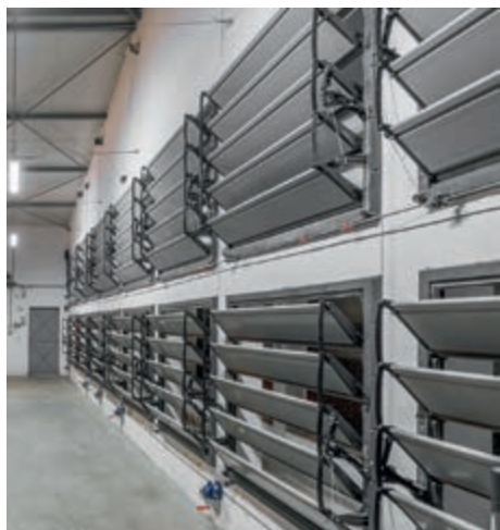
MVT 17 M во фронтовой стене, для туннельной вентиляции
