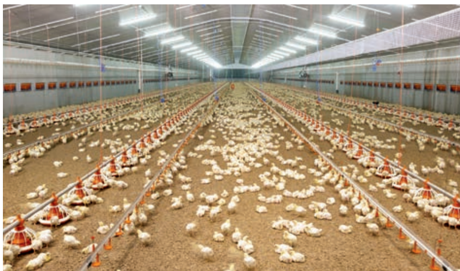
Типичный для регионов Северной Европы корпус для содержания бройлеров с подачей приточного воздуха, реализованной посредством фланцевых клапанов CL-3-1911/F
