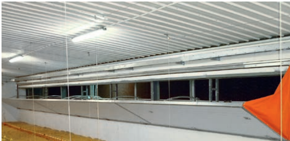
Kurnik dla brojlerów z kłapą otwieraną do wewnątrz
