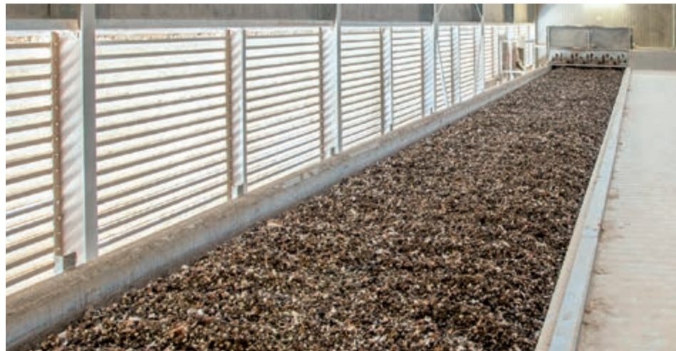
Vista del piano superiore con rastrello per liquefare la pollina avicola
