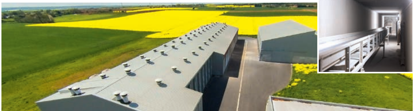
Una soluzione ecosostenibile: due OptiPlate per un capannone che conta 250 000 ovaiole installato sul lato lungo; la pollina essiccata viene poi trasportata sottoterra fino alla concimaia
