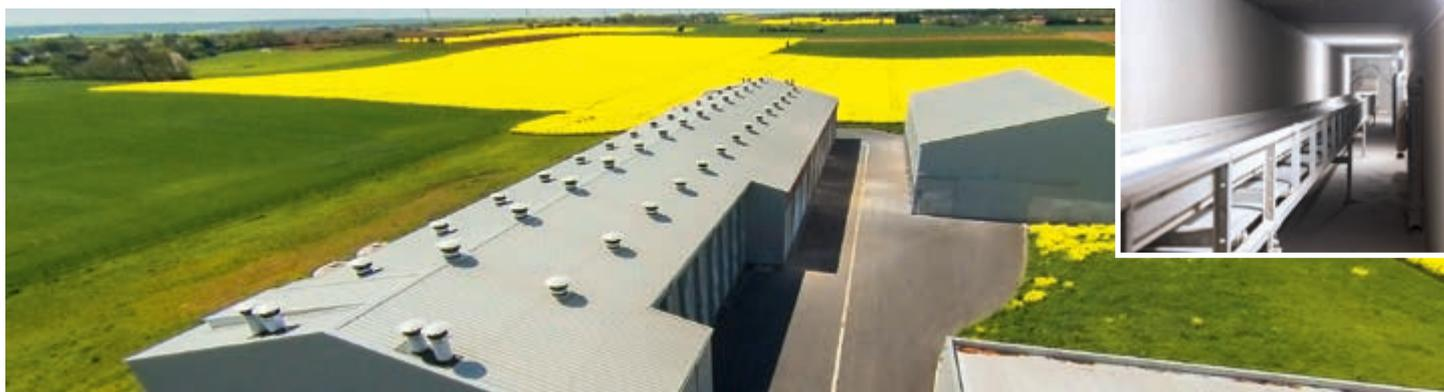
Une solution respectueuse de l'environnement : 2 OptiPlate accolés au bâtiment de 205 000 poules pondeuses ; les fientes séchées arrivent par un conduit souterrain jusqu'au stockage
