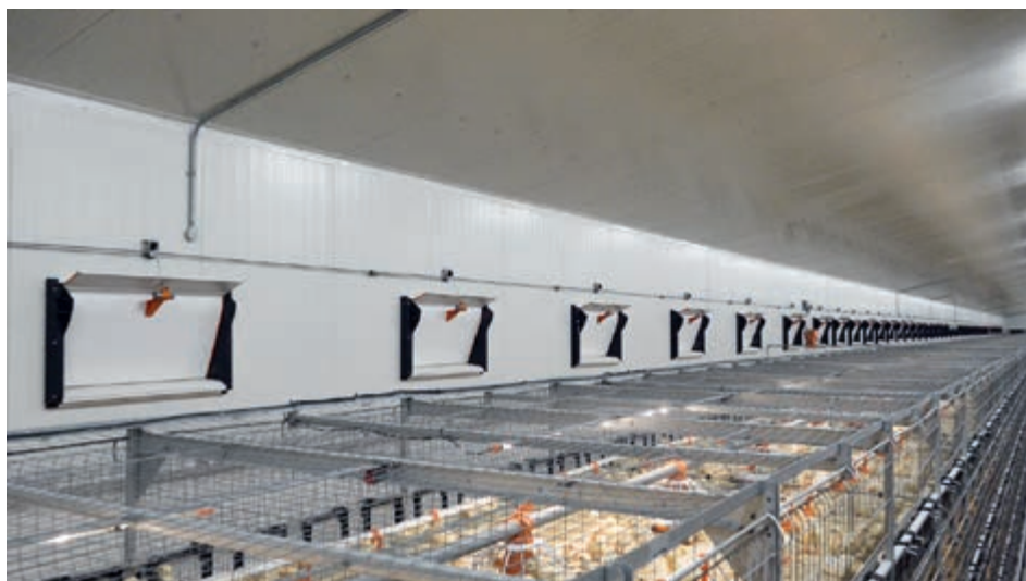
AviMax transit : ventilation par le volet à bride CL Flex
