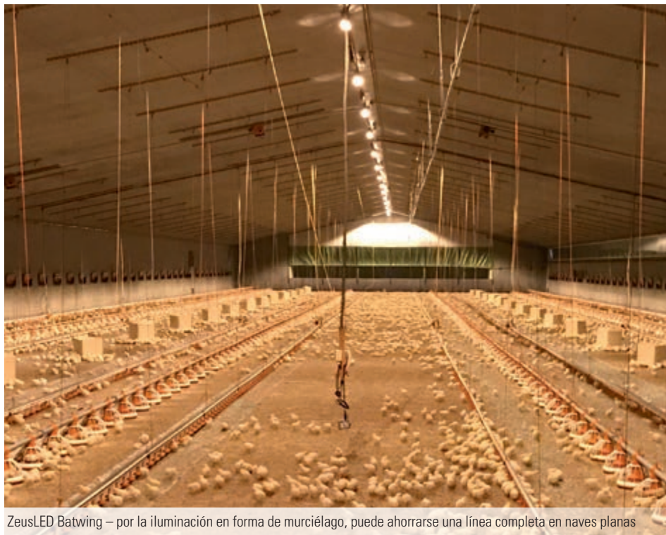
ZeusLED Batwing con solo 20 LEDs especiales por luminaria
