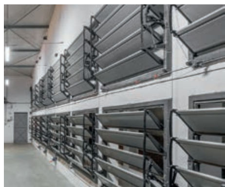
MultiVent 17 M en pared frontal (frontón) para ventilación túnel
