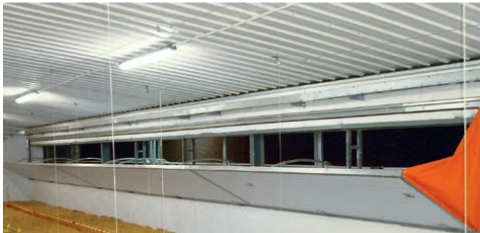
Nave de pollos de engorde con trampilla de túnel que abre hacia el interior de la nave
