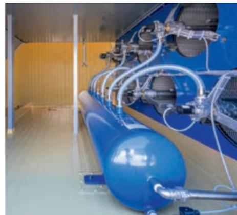
Reinigung der Filter mittels Druckluft
