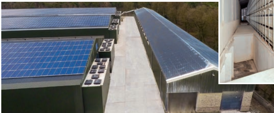
Изгодно решение: OptiSec за 3 сгради носачки всяка за по 90 000 броя, въздухът се отвежда по подземни канали до изсушителя
