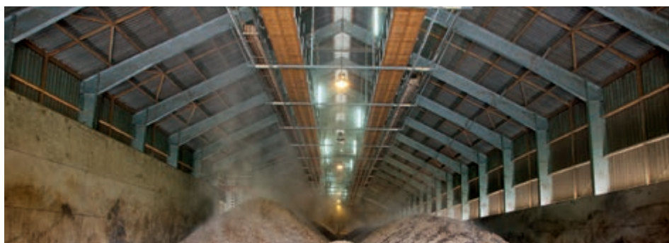
Поглед към инсталацията за разпределяне с помощта на системата за надлъжно транспортиране с 2 ленти
