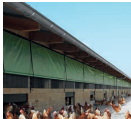
Завеса, която се отваря в долната част
