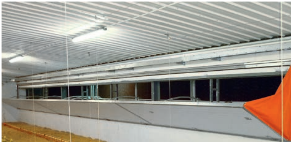
Сграда за бройлери с клапи за тунелна вентилация отворени навътре
