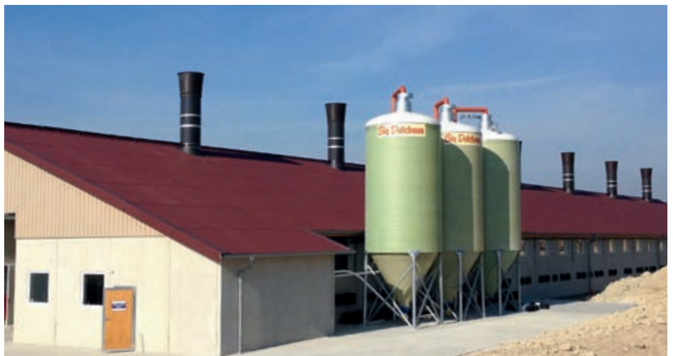
Приклад: викид відпрацьованого повітря >3 м над горизонтальним ребром даху
