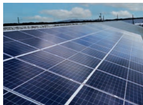
Moc urządzenia – 30 kWp
