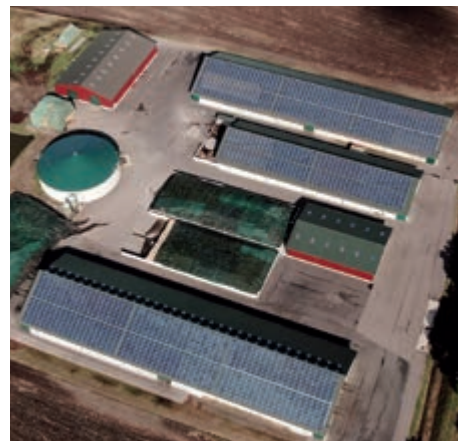
Moc urządzenia – 669,76 kWp
