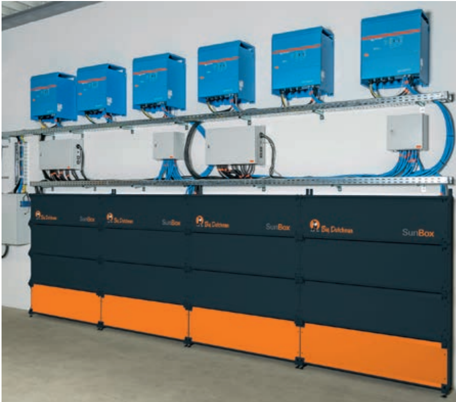
16 modułów o pojemności całkowitej 224 kWh
