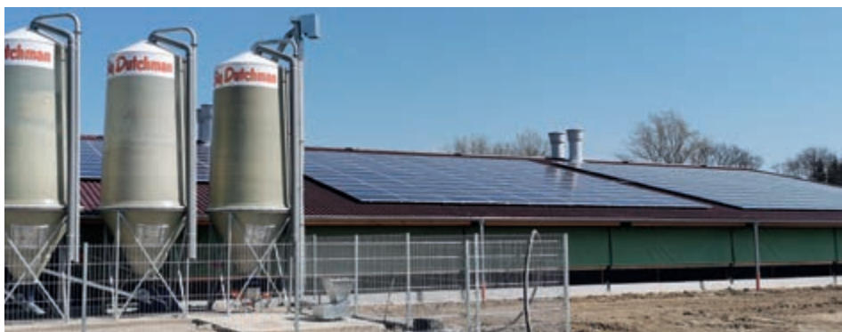
Moc urządzenia – 99 kWp
