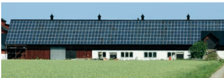
Moc urządzenia – 122 kWp
